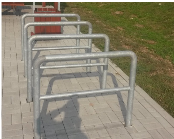
Obrázok 48 - Príklad správneho umiestnenia a tvaru cyklistického stojanu
