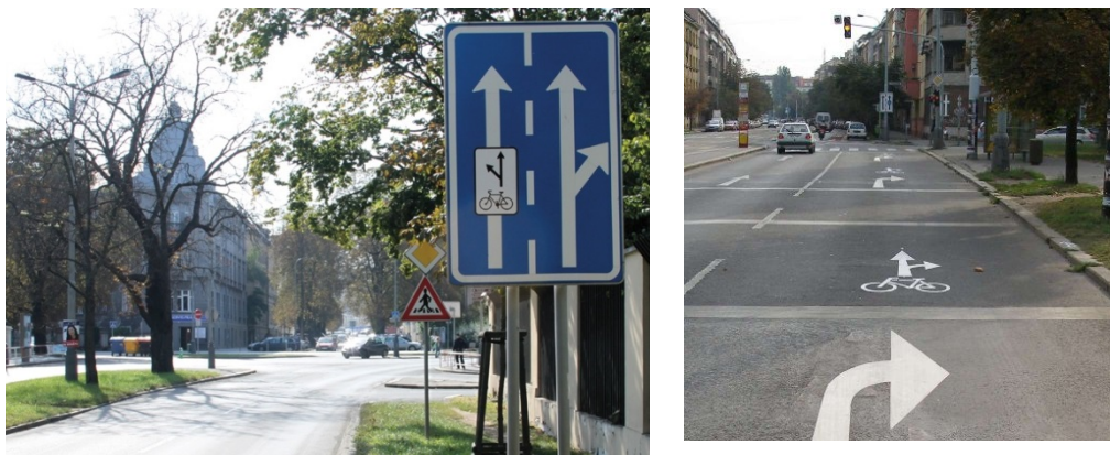
Obrázok 86 - Príklad realizácie nožnej kombinácie so značkou C 25 a vodorovným značením [L9]
