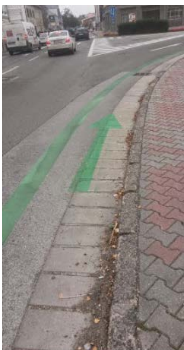
Obrázok 70 - Cyklistický pruh vedený cez odvodňovací žľab (príklad nesprávnej realizácie)
