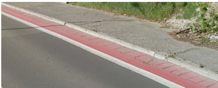
Obrázok 69 - Cyklistický pruh vedený cez odvodňovací žľab (príklad nesprávnej realizácie)
