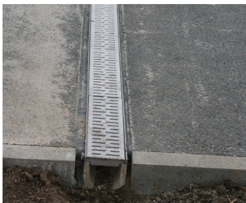
Obrázok 71 - Priečne odvodnenie CYK (príklad realizácie)
