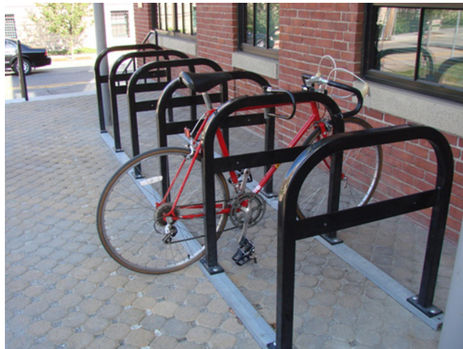
Obrázok 54 - Príklad realizácie priečného umiestnenia stojanov na bicykle [L4]
