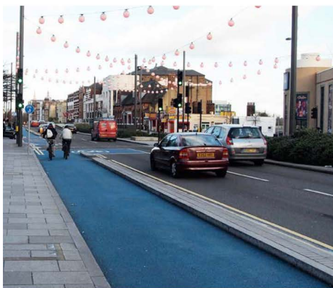
Obrázok 39 - Oddelenie pomocou obrubníkovej úpravy (príklad)
